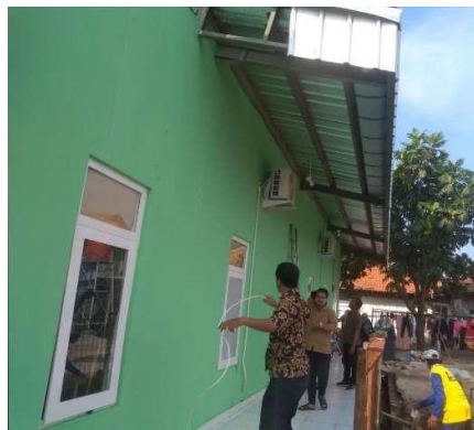
Gambar 7. Pemasangan rangkaian solar panel ke gedung
