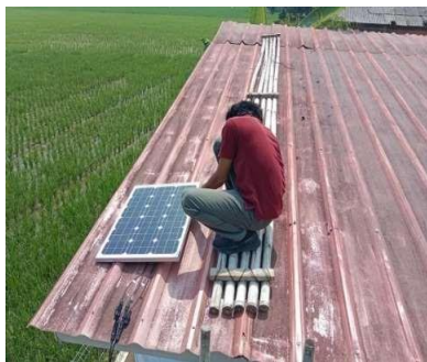
Gambar 5. Lokasi pemasangan panel
